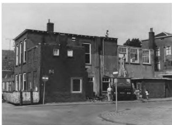
Afbeelding 1: Aanvang van de sloop van 'De Poort'. (Foto M 1187 met dank aan het Regionaal Archief Rivierenland, Tiel; Tevens gepubliceerd in de Tielse Courant; 14 juni 1983).
