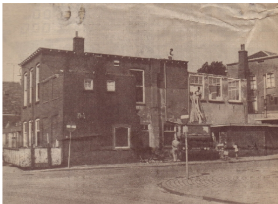
Afbeelding 1: Foto van de sloop van “clubhuis De Poort”. Tielse Courant, 14 juni 1983
