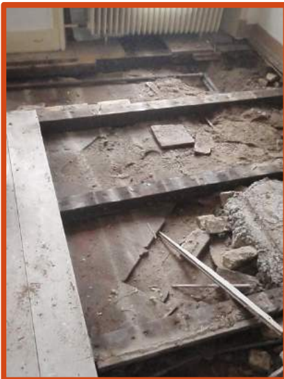
Figuur 6 Vloeropbouw voorkamer
