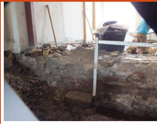
Zijaanzicht tussendrempel/muur vanuit achterkamer
