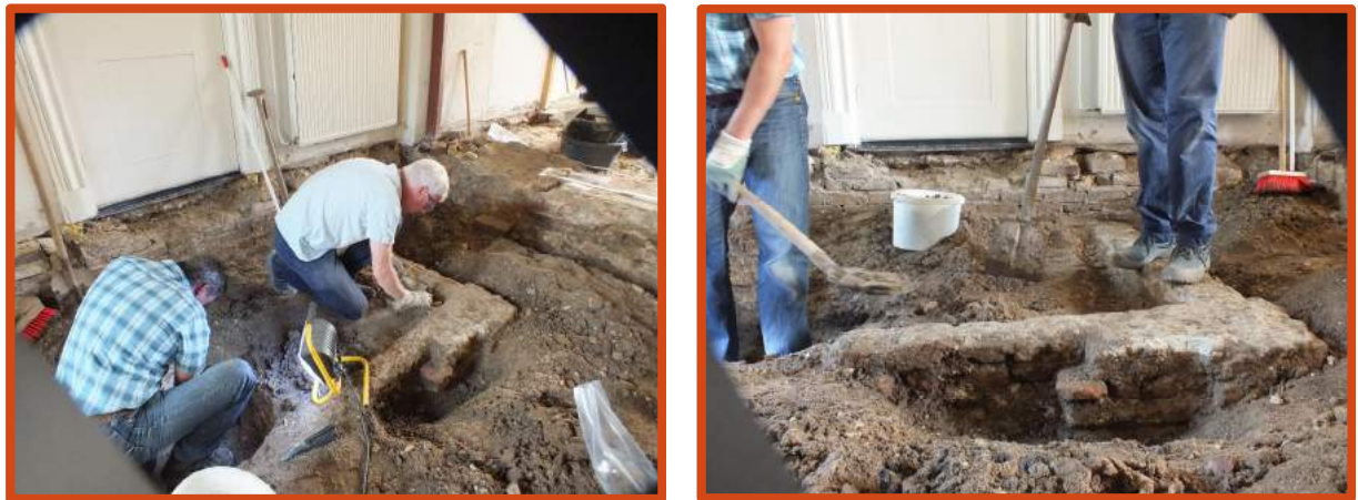
Figuur 15 Werkzaamheden achterkamer aan de fundatie van een oude muur
